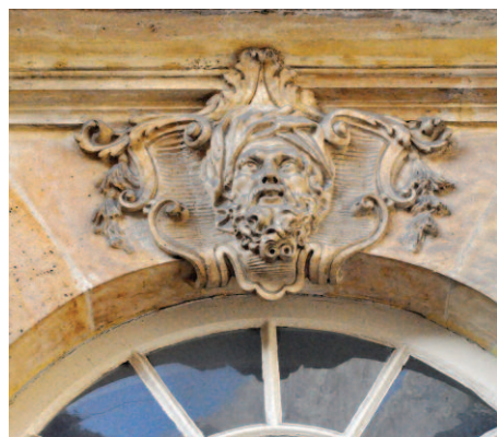
Façade d'un hôtel particulier (Paris).
